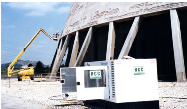
Fig.14. Primer plano de la bomba trabajando en CN Cofrentes.
