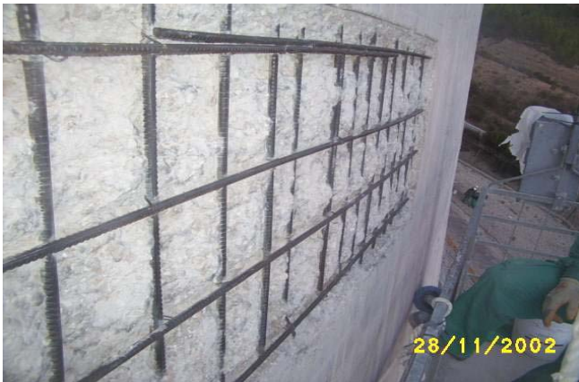
Fig.13. Resultado de la aplicación de la hidrodemolición a una zona dañada
