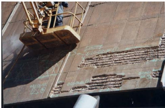
Fig.8. Marcado y fotografiado previo de las zonas a tratar. La foto es posteriormente incluida en una base de datos que asegurará la trazabilidad del proceso.
