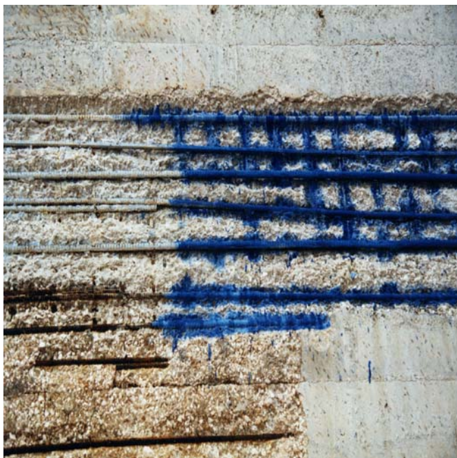
Fig.9. Zona saneada y barras ya tratadas con pasivante azul cobalto.
