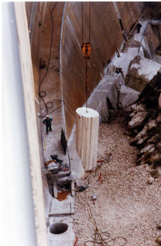
Figura 8. Momento del izado del bloque de hormigón, precortado con taladros tangentes, para nuevo acceso al nicho de un péndulo.
