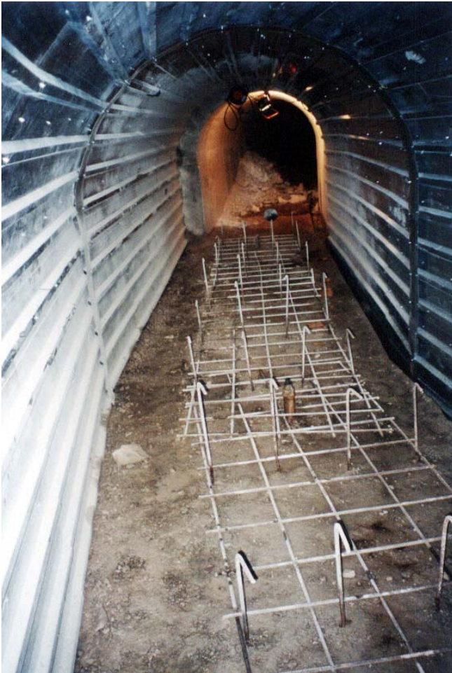
Figura 3. Vista de la galería antes del macizado. Se aprecia la chapa plegada en clave y hastiales, así como los conectores en el suelo.
