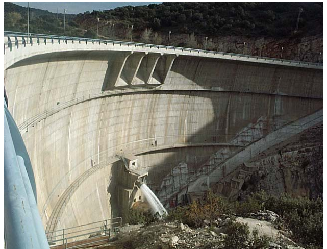
Figura 2. . Vista general de la presa y de los trabajos exteriores en la margen izquierda.
