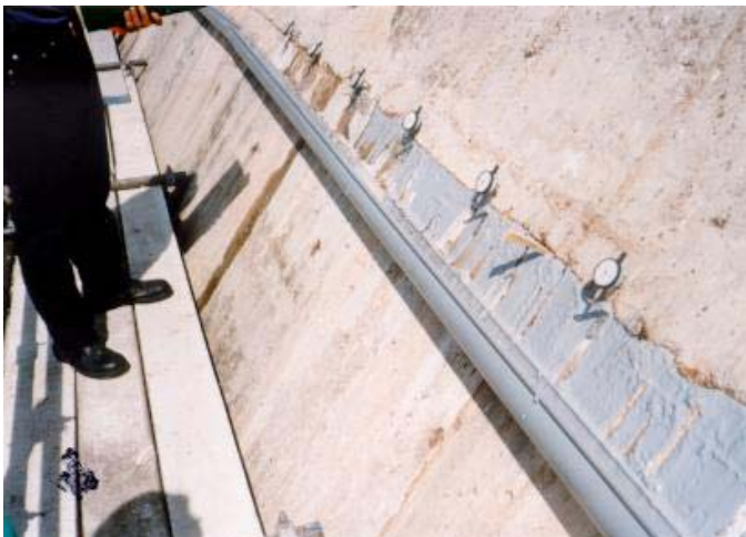
Figura 7. Micrómetros dispuestos en la fisura y canaleta de recogida de excedentes de resina, durante el proceso de inyección.
