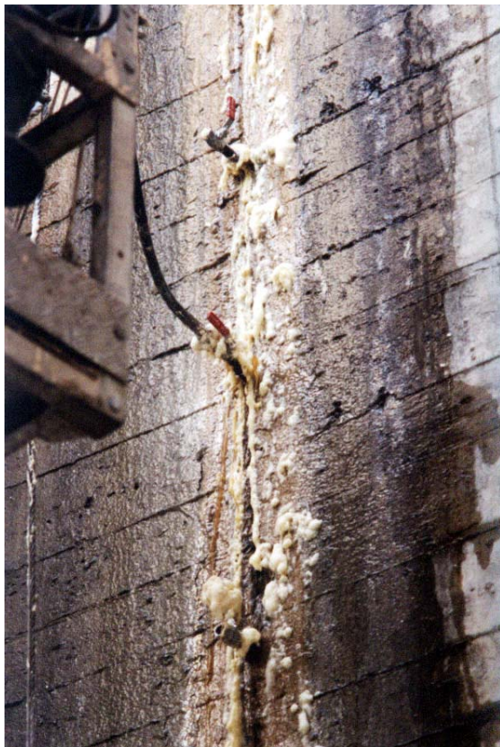
Proceso de inyección con resinas acuarreactivas
