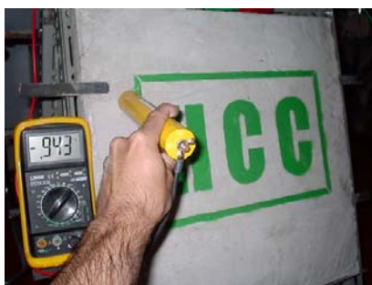
Figura 11. Protección catódica por corriente impresa. Potenciales de protección entre -850 y -1200 mV.
