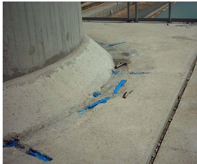
Figura 6. Imprimación pasivante de armaduras en zonas de reparación localizadas.
