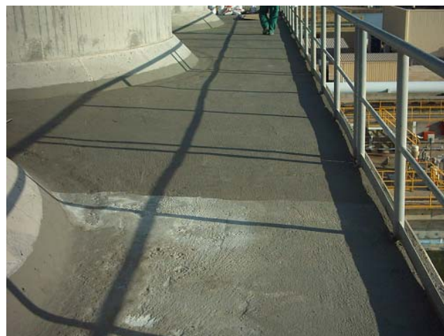
Figura 7. Proceso de impermeabilización con mortero cementoso elástico.
