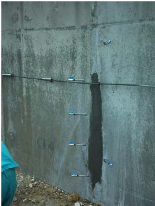
Figura 7. Proceso de inyección de polímeros en fisuras. Colocación de obturadores y pruebas de agua.
