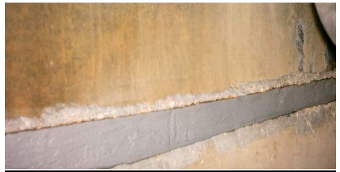
Figura 7. Sellado de junta de hormigonado con mortero epoxi.
