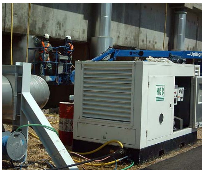
Figura 5. Operarios trabajando con el equipo de hidrodemolición.
