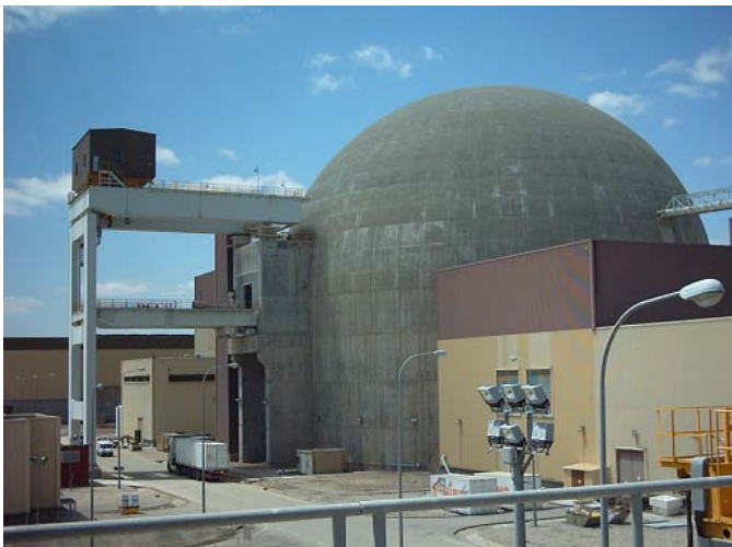
Figura 1. Vista general de la cúpula del reactor
