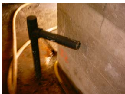
Figura 5. Detalle de emboquillamiento de dren
