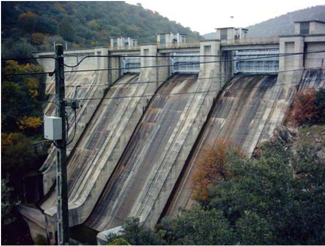
Figura 1. Vista general de la Presa de Picadas
