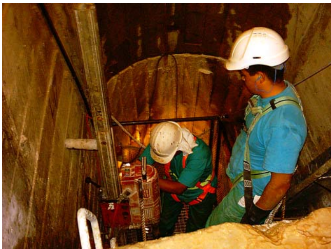
Figura 4. Trabajos de perforación desde plataforma. Se aprecia el reducido tamaño de la máquina de perforación, los elementos de seguridad del personal, y más abajo el tramex de la plataforma.
