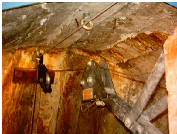
Figura 6. Detalle del sistema de elevación de materiales del interior de las galerías
