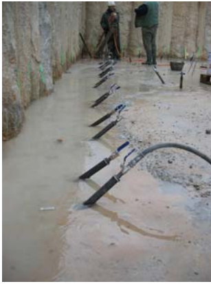
Contacto de la prelosa con la pantalla de pilotes antes y después de la inyección
