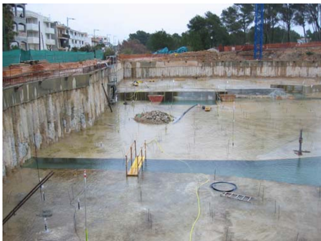
Vista parcial de la obra antes de la intervención
