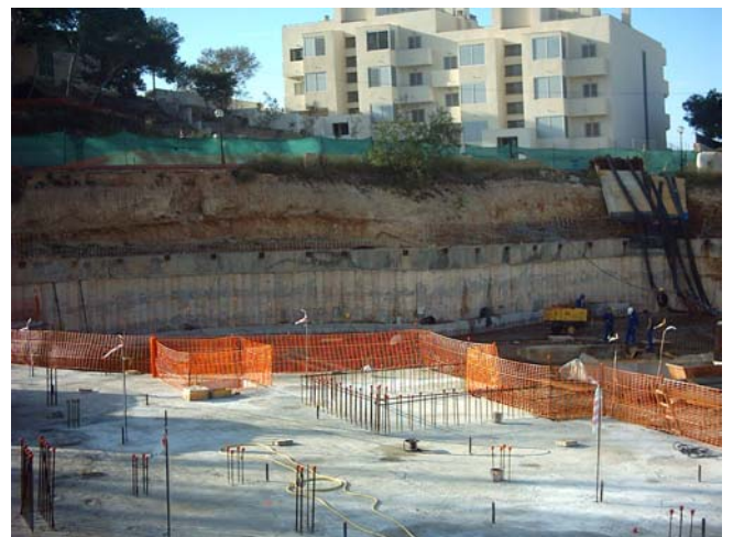
Aspecto de la obra tras la intervención de HCC. Se aprecia la prelosa totalmente seca y los trabajos de la colocación del armado de la losa superior
