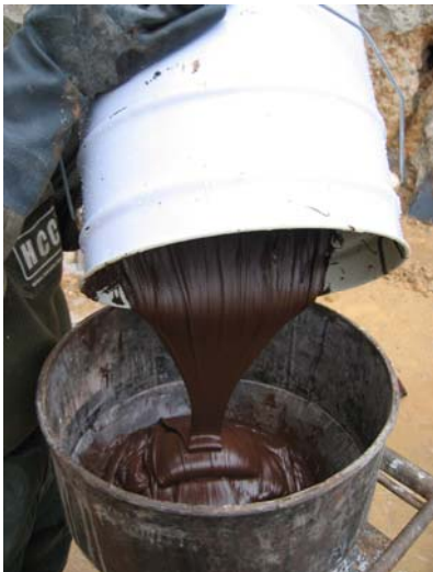
Masilla de alta viscosidad tixotrópica en el momento de su vertido al depósito de admisión de la bomba de inyección.
