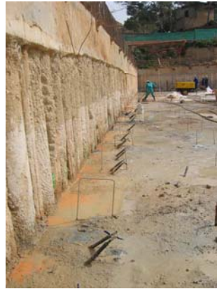
Contacto de la prelosa con la pantalla de pilotes antes y después de la inyección
