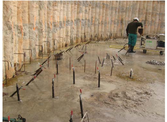
Aspecto de la obra durante la inyección conjunta del contacto perimetral y del cuerpo de la prelosa
