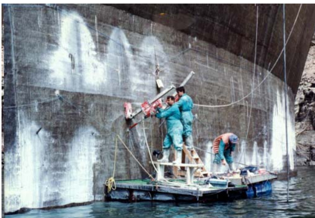
Figura 12. Perforación de taladros de inyección desde batea. Presa de S. Esteban. Ourense. IBERDROLA
