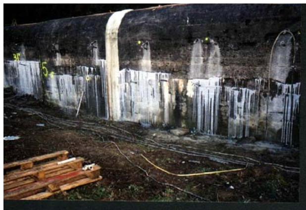
Figura 14. Aspecto parcial de la reparación del aliviadero de Portodemouros. Pontevedra. UNION-FENOSA
