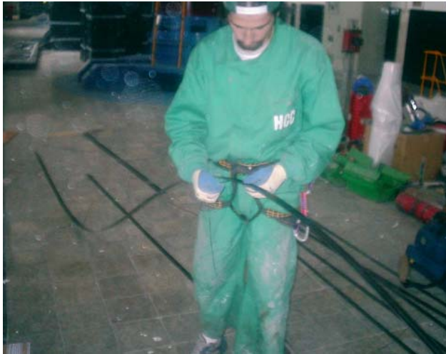
Figura 5. Preparación del laminado antes de la colocación. Se aprecia la facilidad de manejo del material que es suministrado en rollos de gran longitud y bajo peso, que son cortados en obra con las dimensiones de proyecto.
