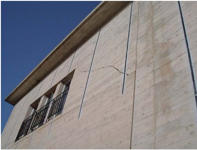
Figura 1. Refuerzo con laminado para cumplir requerimientos sísmicos. CH Zorita. Unión FENOSA.
