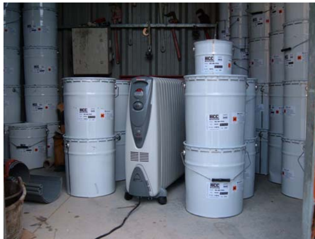
Figura 8. Almacén de resinas con radiadores en funcionamiento para mantener óptimas condiciones
