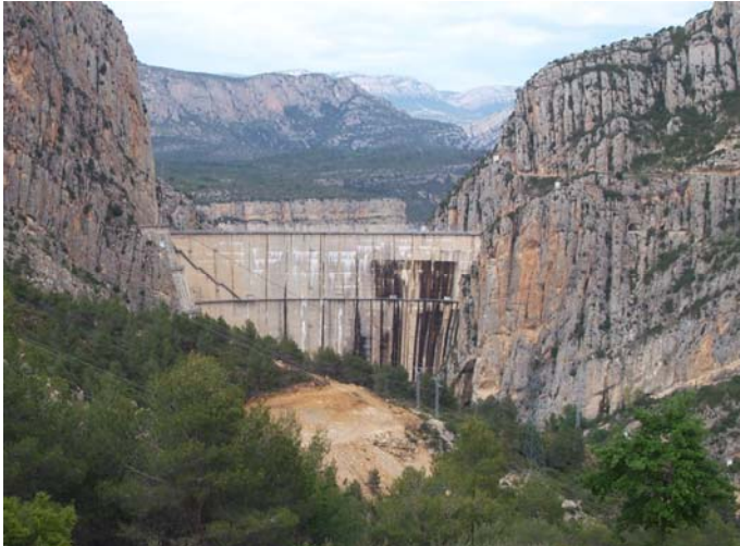
Figura 1. Vista general de la Presa de Canelles. Lérida
