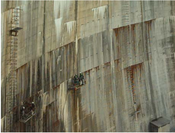
Figura 10. Operarios de HCC limpiando el paramento de aguas abajo desde andamio
