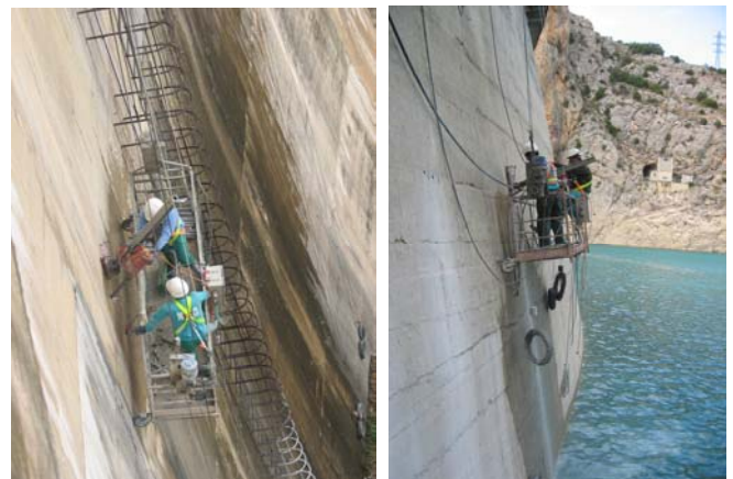
Figura 6. Perforación desde andamio, tanto aguas arriba como aguas abajo
