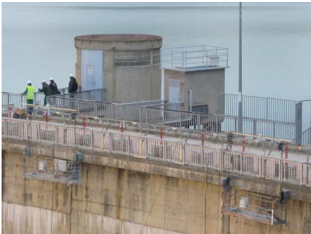
Figura 4. Sistema de andamios colgantes motorizados aguas debajo de la presa
