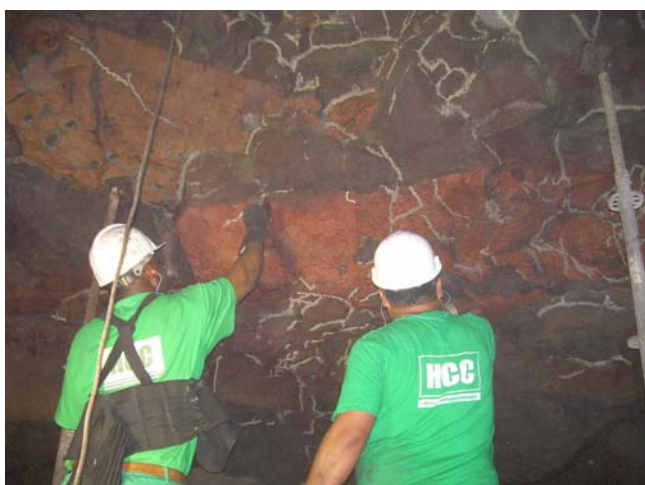
Fig. 14. Coloración de la soldadura química..
