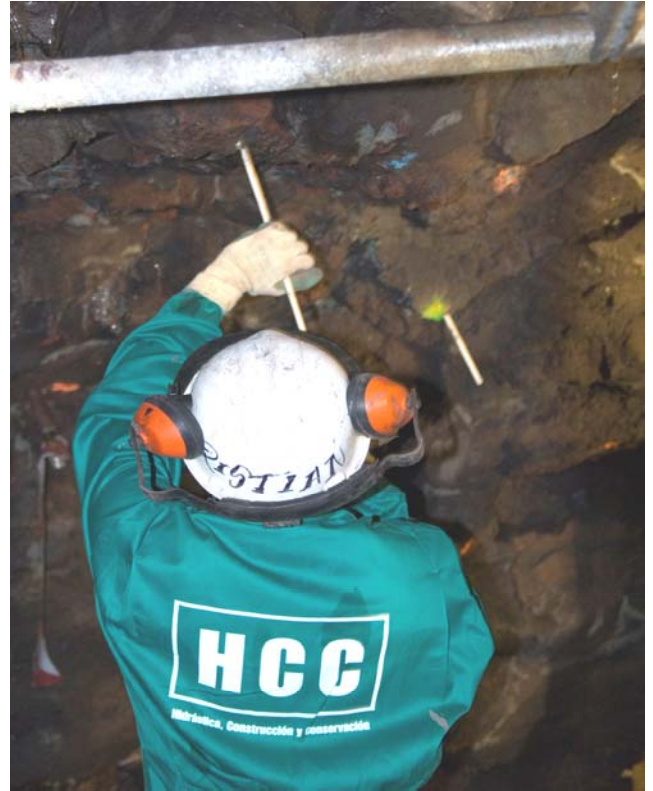
Fig. 11. Ejecución de microcosido.
