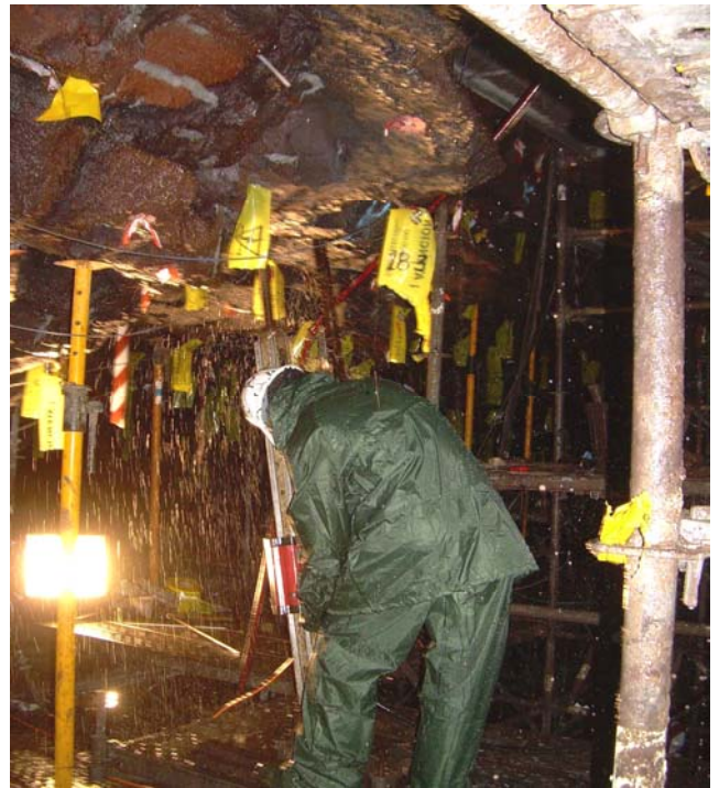
Fig. 7. Perforación a rotación de taladro de 4 m y d 46 mm.
