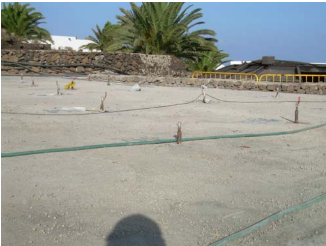
Fig. 10. Obturadores en la losa de hormigón.
