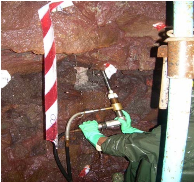
Fig. 4. Perforación de taladro de 1 m y d 22 mm, mediante radial neumática.
