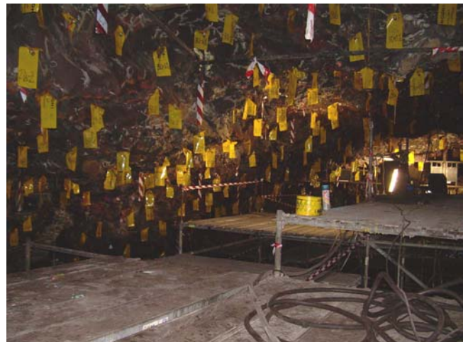
Fig. 8. Vista general del bulonado en la bóveda del auditorio.
