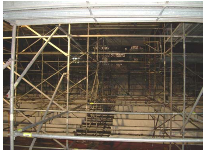
Fig. 2. Auditorio cubierto de andamios.
