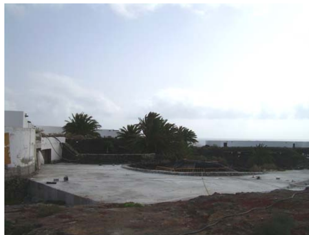
Fig. 16. Colocación de clinómetros en la losa-estrato.
