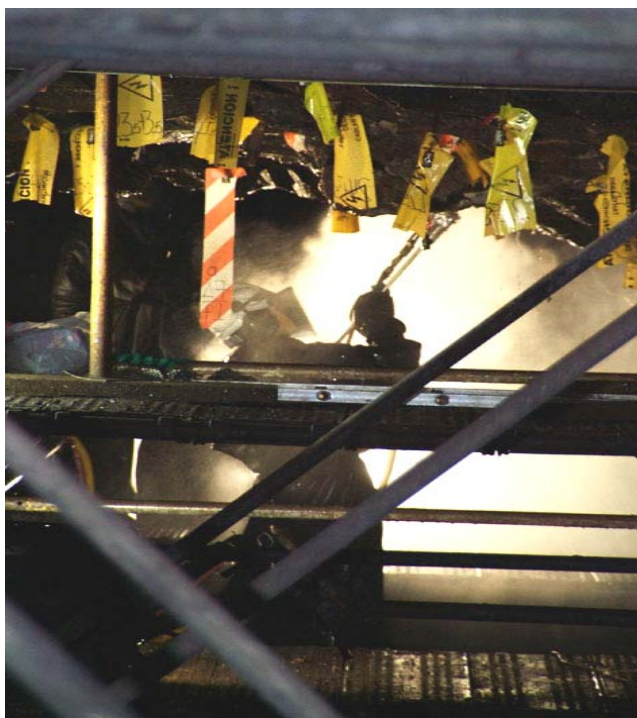
Fig. 13. Hidrodemolición.
