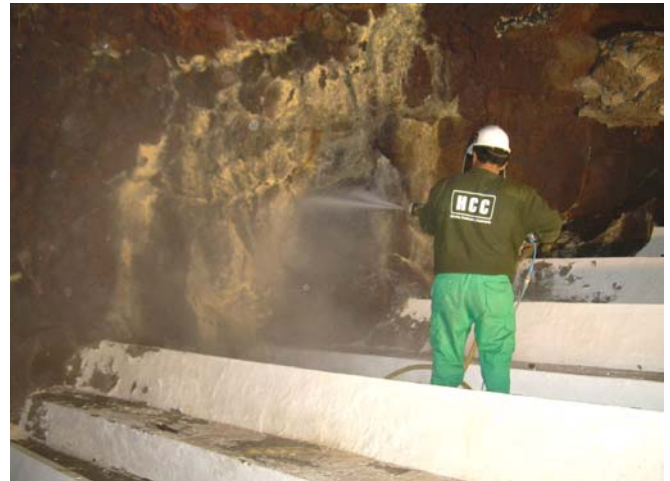
Fig. 3. Eliminación de eflorescencias mediante hidrodemolición
