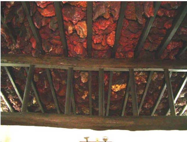
Fig. 9. Vista general trabajo finalizado.
