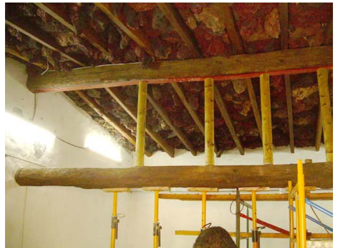
Fig. 7. Refuerzo metálico de viga de madera.
