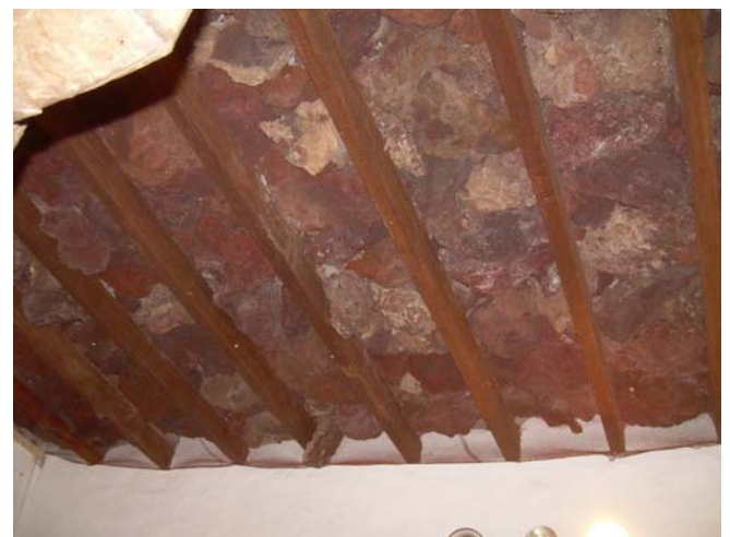
Fig. 4. Malla de seguridad.
