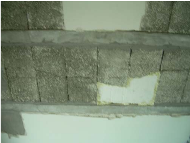
Fig. 10. Relleno con porexpan y espuma de poliuretano.
