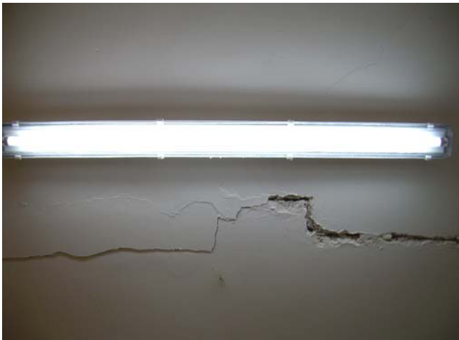
Fig. 4. Bovedilla rota y suelta.
