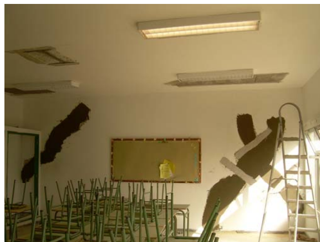
Fig. 7. Reparación de grietas y cosido de facturas.
