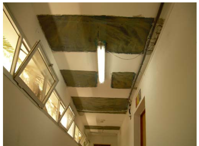
Fig. 13. Fibra de carbono con resina epoxi y arena espolvoreada.
