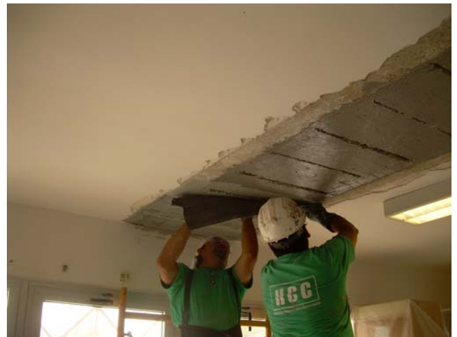
Fig. 12. Colocación de fibra de carbono con resina epoxi entre viguetas .
