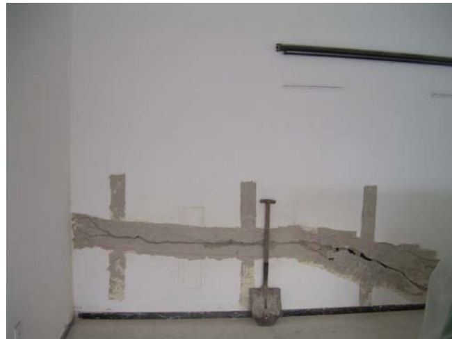
Fig. 6. Retirada de enfoscado para cosido de grietas.
