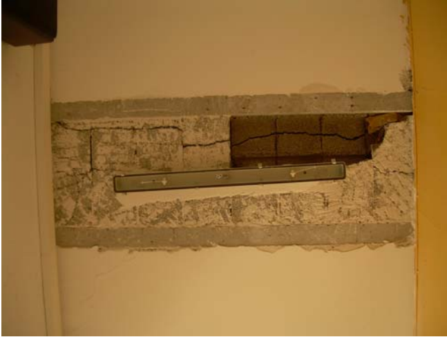
Fig. 9. Bovedillas rotas y sueltas.
