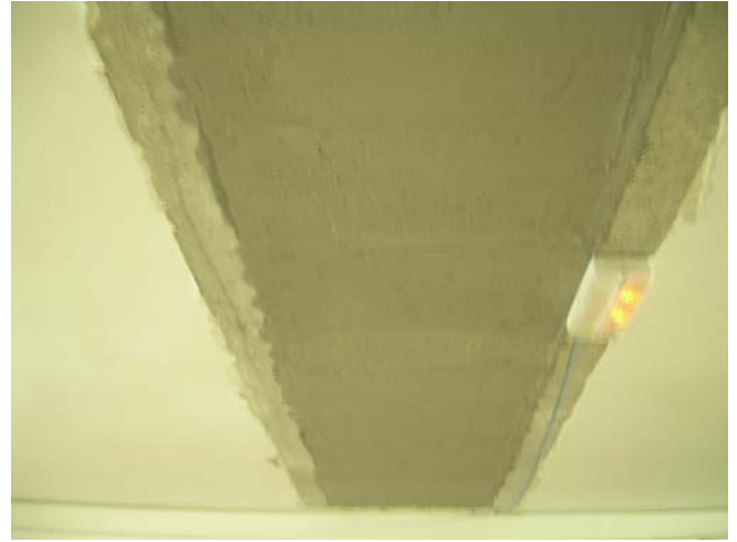
Fig. 11. Regularización bovedillas y viguetas con mortero epoxi .
